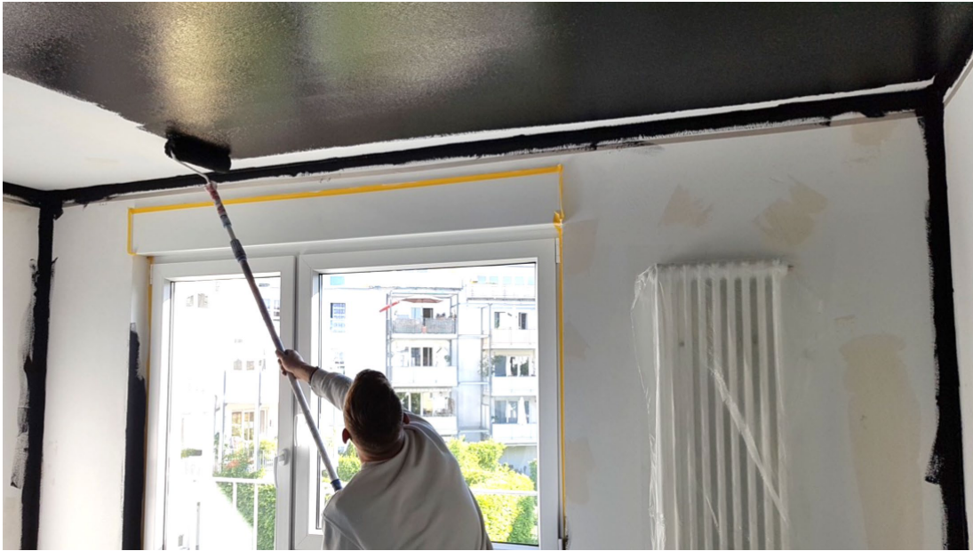
Abb. 09: Raumabschirmung mittels Abschirmfarbe Foto: Christian Blank
