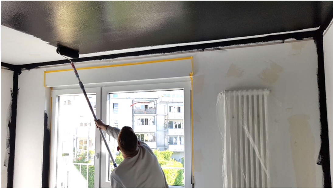
Abb. 09: Raumabschirmung mittels Abschirmfarbe Foto: Christian Blank
